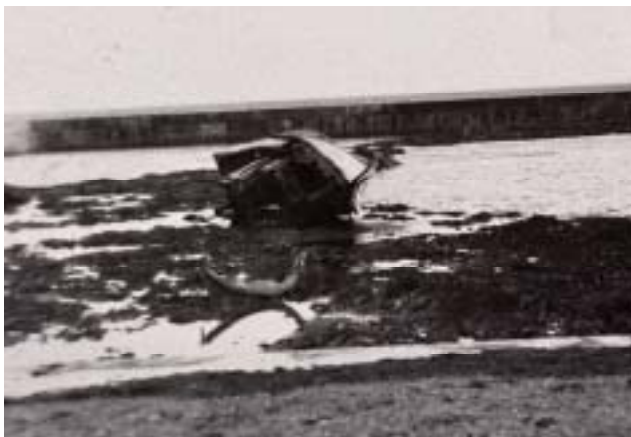
チリ沖地震津波被害(昭和 35 年)
