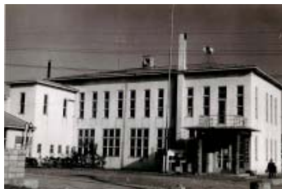
昭和 31 年に新築された旧役場庁舎
