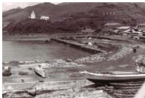
幌泉港(昭和 38 年)
