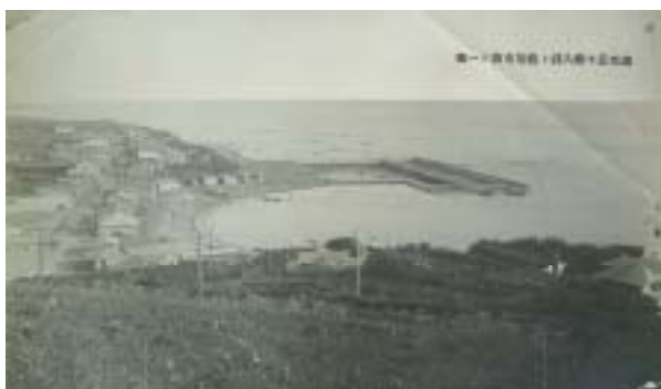
幌泉港(昭和6年)
