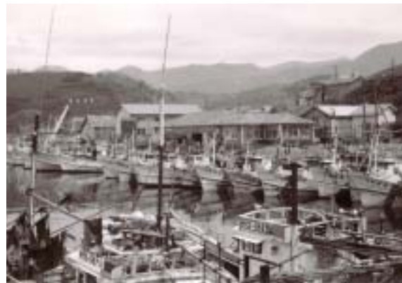
幌泉港（昭和 35 年）
