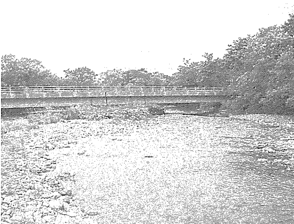
図3-9. 調査地G 歌別川 歌別二号橋 (上流から下流を望む)
