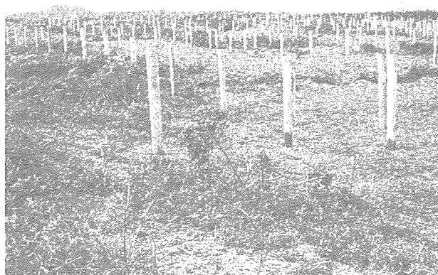
図9. 調査区C (防風垣設置工事中)
