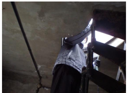
灯台記念塔の内部を清掃(写真 上・下)
