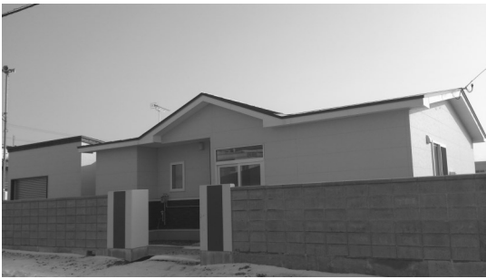
えりも小学校公園脇に建設された小児科医師用住宅
