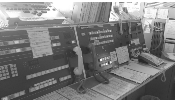
平成28年4月1日からの運営を目指して整備が行われる
