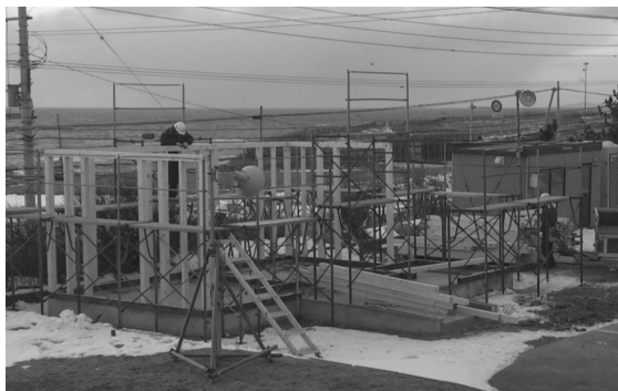
3月完成予定のスポーツ公園公衆トイレ
