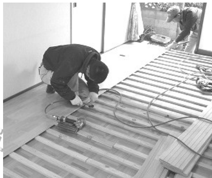
住宅改修工事助成事業
