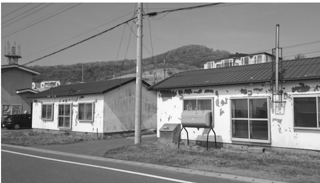
えりも小学校裏の教員住宅 取り壊し予定の2棟2戸
