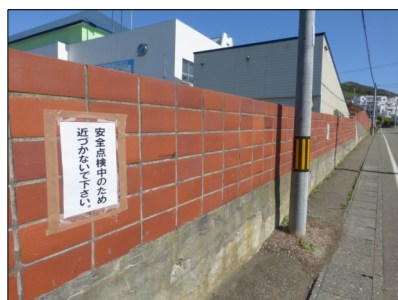
改修が待たれる福祉センター横のブロック塀
