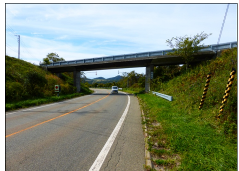
解体予定の無名橋
