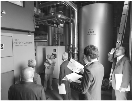
高性能の木質バイオマスボイラー
