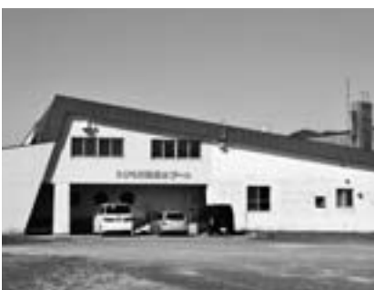
老朽化が進む温水プール
