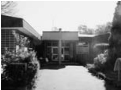
改修を検討している庶野保育所
