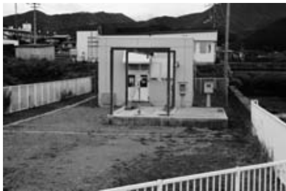
南部家川沿いにある本町中継ポンプ所。3月の震災では処理機能に影響はなかった
