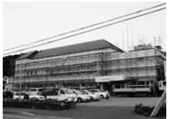
建築後40年を経過する福祉センター。現在、外壁の改修工事を行っている
