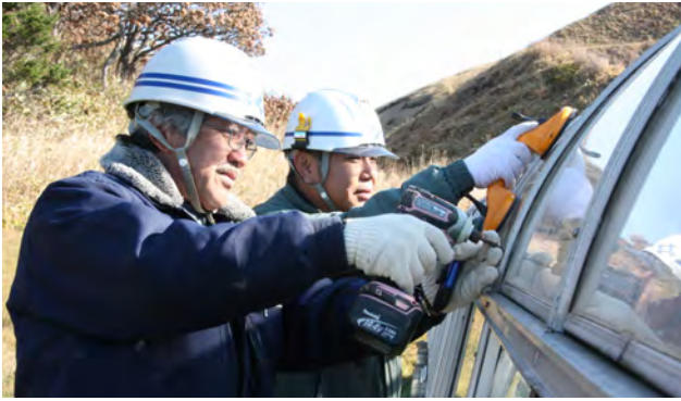
新しいガラスに交換する池田建設の作業員の皆さん
