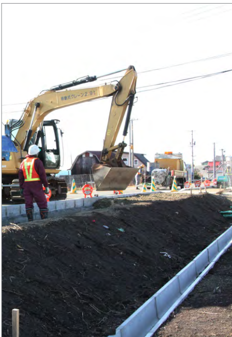
国道336号線笛舞地区歩道工事 歩道設置により安全な登下校ができます
