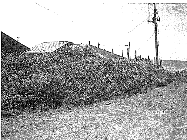
図3. えりも町宇歌別の土手 海岸段丘の縁に位置し、斜面を切り開き、1階建ての家屋の軒先の高さまで土手が積まれている。
