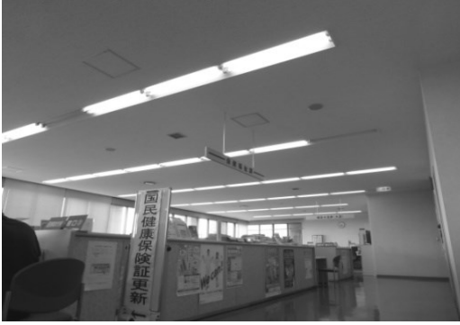
LED化が望まれる役場庁舎の照明
