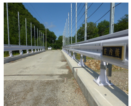
森林基幹道えりも線 荻内橋
