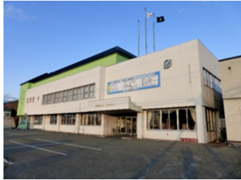
複合施設の建設中止により耐震化等が課題となる福祉センター
