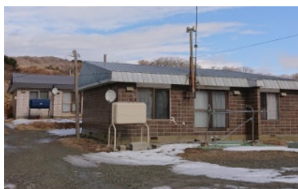
老朽化が進む歌別地区の町営住宅
