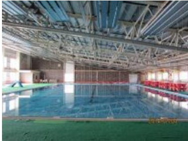
旧町民プールの内観
