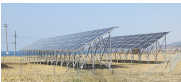
管理看板の未設置が見受けられるソーラーパネル
