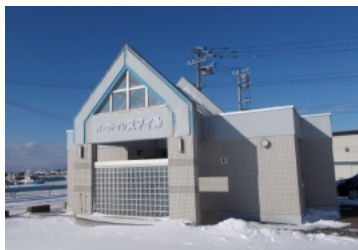
老朽化が進むパークトイレ
