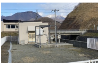
えりも港付近のポンプ室。更なる防災対策を
