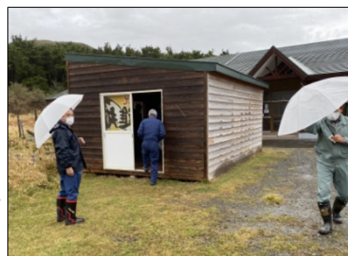
傾いている岬地区の防災倉庫。状態の確認を
