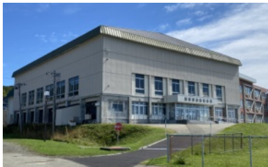
町民体育館は大規模改修が必要である
