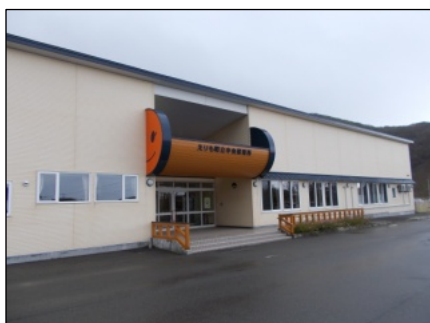
保育所にもエアコンが必要ではないか
