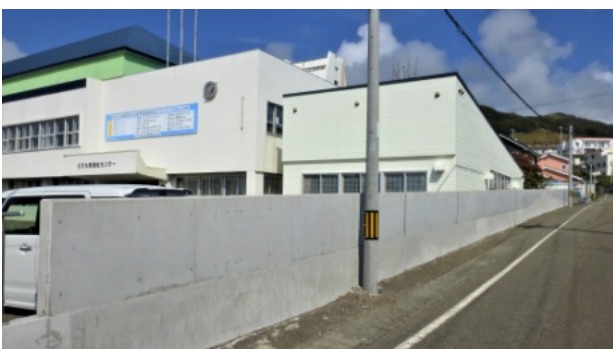
公共施設のブロック塀は改修されたが、個人所有の危険なブロック塀は...
