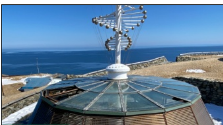
「風の館」天窗ガラス崩落箇所の早期修繕を
