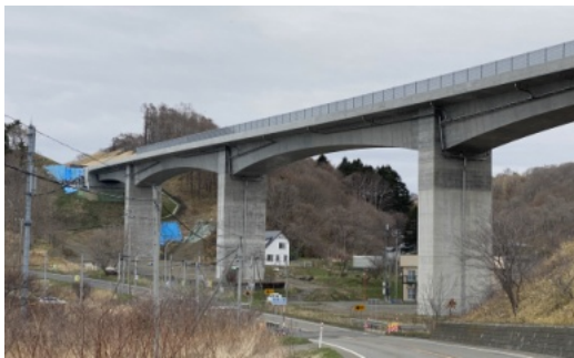
災害時には緊急避難道路となる日高自動車道 II 新冠町節婦地区
