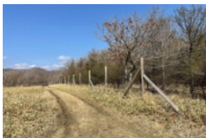
修繕箇所が多いシカ侵入防止柵
