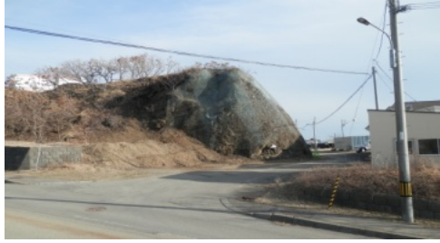
崩落の危険性がある「町道旭ヶ丘7号線」
