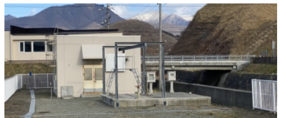
大和地区の下水道ポンプ室 監視装置を更新
