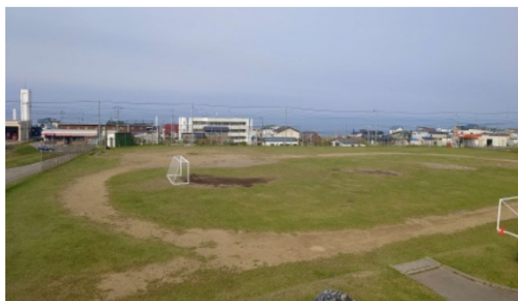
1億円弱の規模で大改修されるえりも中学校グラウンド
