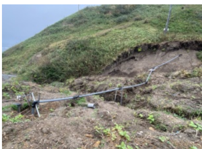
東洋・歌露地区の災害現場は、法面の地滑りによって配水管が破損し、一時30戸が断水となった
