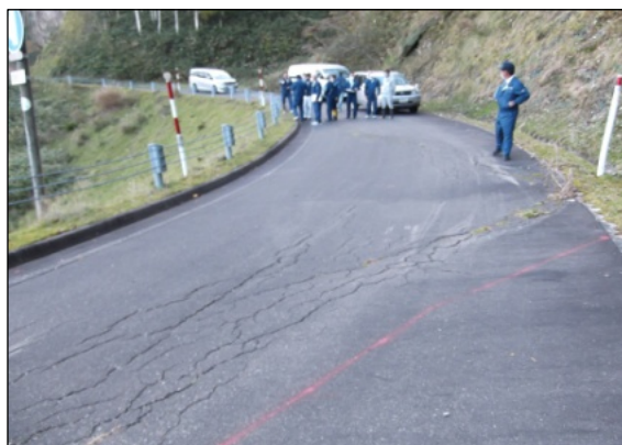
亀裂が生じた基幹道えりも線
