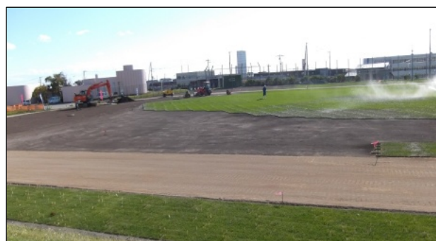
中学校グラウンド改修工事は、芝を根付かせるため散水しながら施工していた
