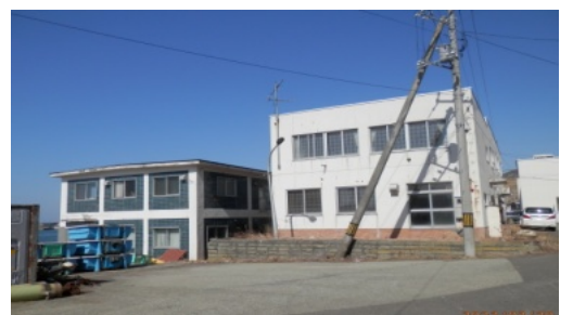
解体に向けた設計が行われる「漁村センター」と「えりも漁協旧事務所」
