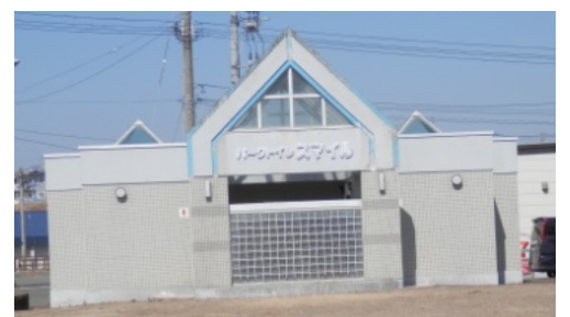
建て替えが決まった灯台公園公衆トイレ「スマイル」
