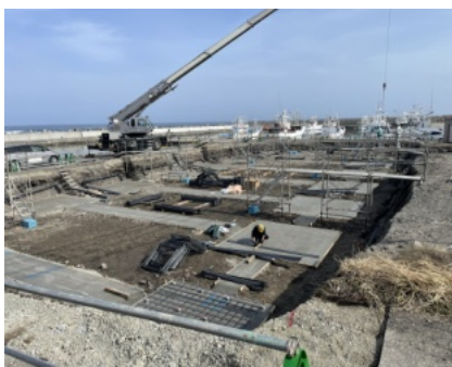
建設が進む「えりも岬地区の水産物荷さばき施設」
