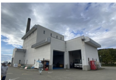
清掃センターは、老朽化が著しく度々改修工事が行われている
