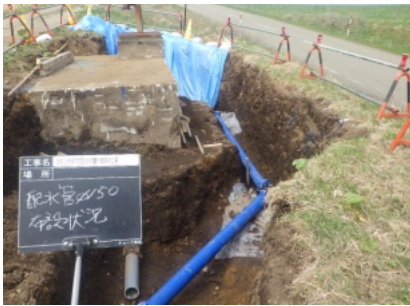
順次、地震に強い配水管に更新中
