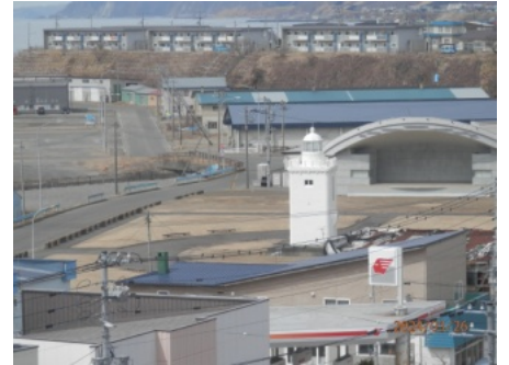
ステージ横に公衆トイレを新設
