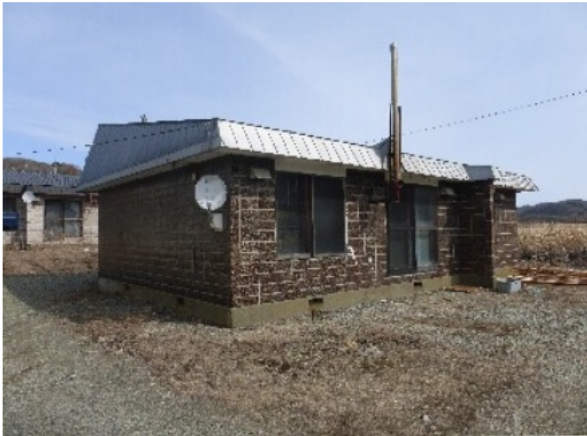
まずは空いている町営住宅や教員住宅を改修してお試し体験住宅に活用している自治体が多い
