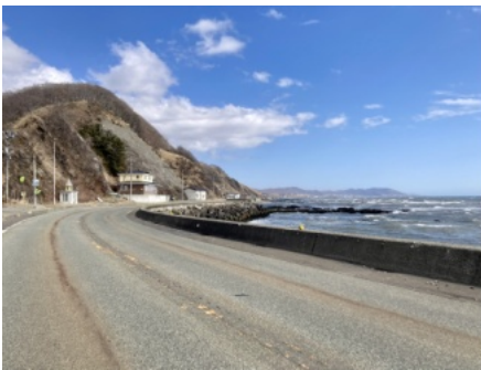
被災により通行止めが予想される国道336号
