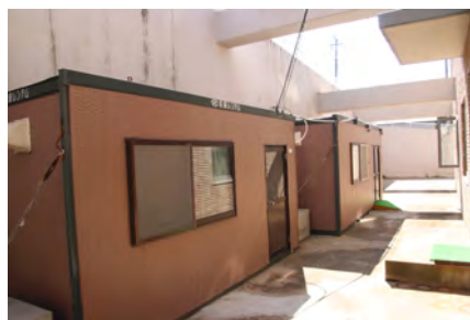
診療所敷地内に設置された 仮設診察室
