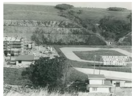
新校舎への改築工事の様子
