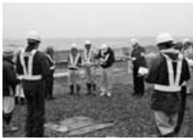
えりも建設協会の建設現場安全パトロール (10月25日)
