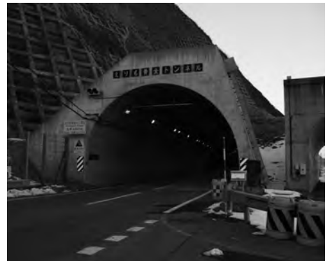
えりも黄金トンネルが開通したが、陥没した国道の移管は未決定。
