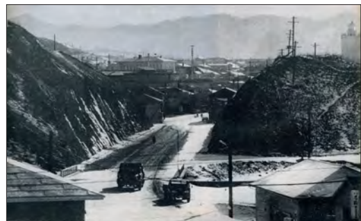
国道の直線化完成
