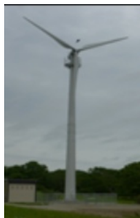
本町地区の小型風力発電施設
