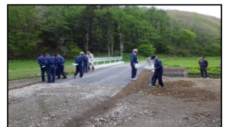
完成した苫別3号橋
