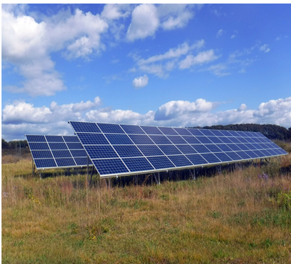
強風により損壊した事例があり、近隣住民に対する被害が懸念される太陽光発電
