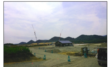
急ピッチで建設が進むえりも分場
