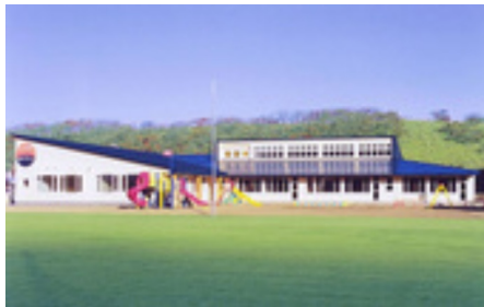
避難路の手摺取付が検討されているえりも中央保育所
