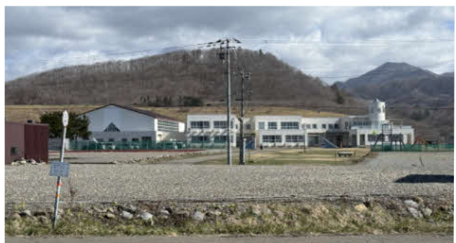
国道からほど近く、2階からは太平洋が一望できる笛舞小学校の校舎
