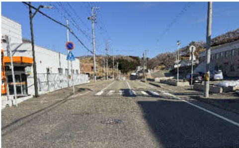
町道山の上裏通り線（役場前通り）で下水道陥没事故は発生していない
