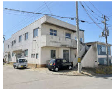
解体される漁村センター（手前）と旧えりも漁協事務所（奥）
