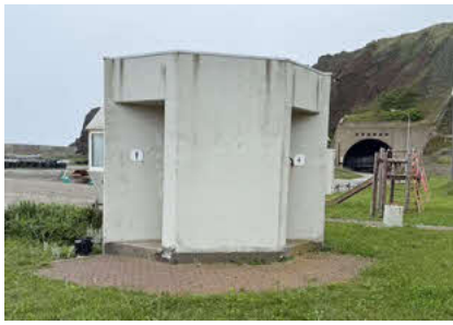
庶野・東洋など4ヶ所の漁港トイレを修繕する
