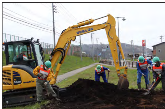
小型重機などを投入して行われた作業 作業時間は約5時間にもおよびました
